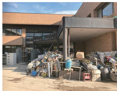
1 階部分が水没したかがやき豊野
